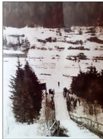
Pohled z nájezdové věže
